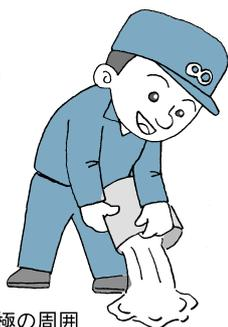
接地極の周囲を覆うように低減材を接地箇所投入してください。低減材を投入後、土を埋め戻してください。(投入後すぐに埋め戻しても問題ありません。)
